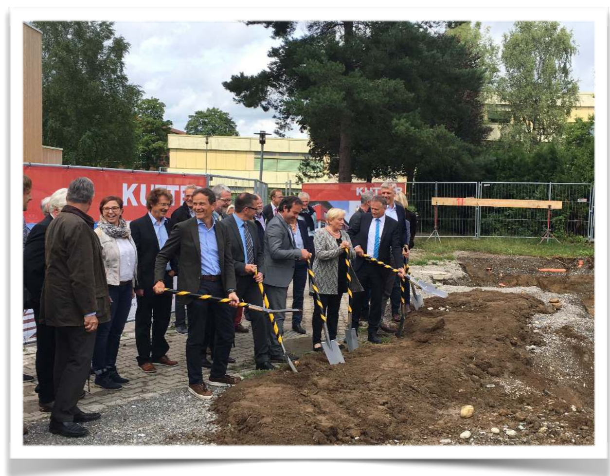
Spatenstich Neubau am 24.7.2017
